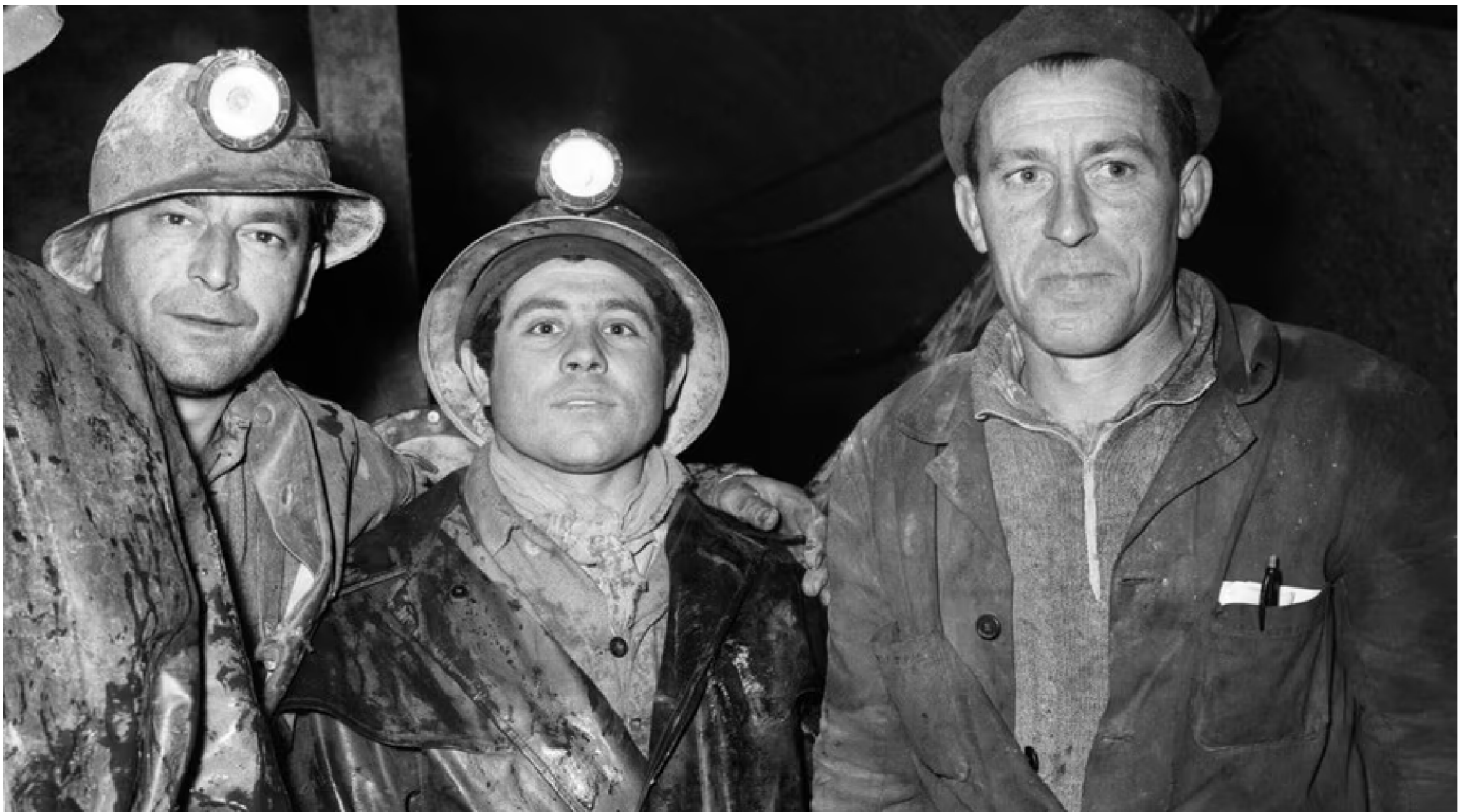
Saisonniers italiens sur le chantier de la centrale électrique de Göschenen dans le canton d'Uri en juin 1965. Keystone
